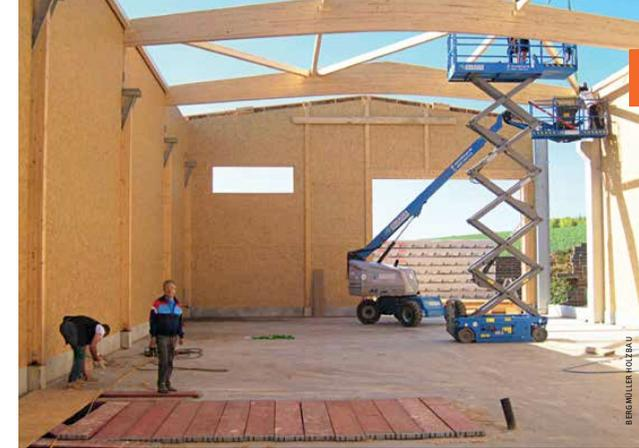
und einem robusten Industrieparkett in Eiche. Sämtliche Wände haben die Verarbeiter als Holzrahmenwände ausgeführt mit Gipsplatten als Sichtflächen, dazwischen Mineralfaser als Hohlraumdämmung. Die Fassade führten die Zimmerer mit einer fein gesägten Schalung aus Lärche aus, die sie mit drei unterschiedlichen Brettbreiten sowie einer
